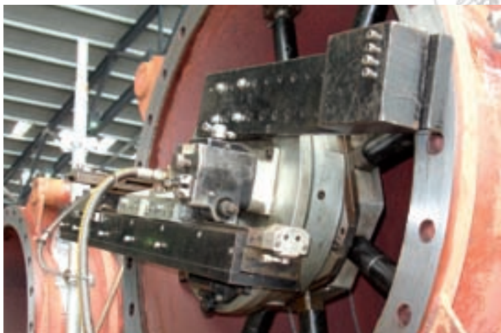
Surfaçage de portée de joints
